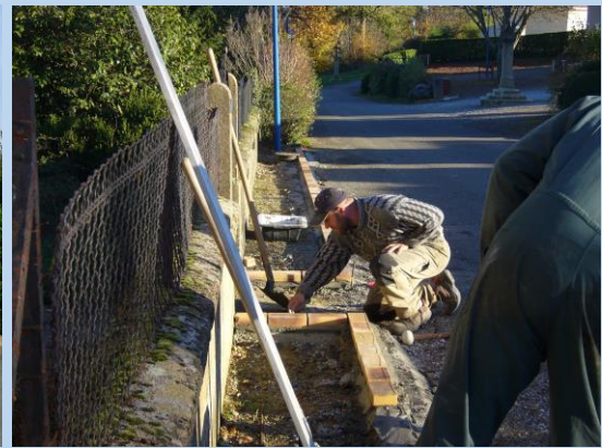
Pendant les travaux
