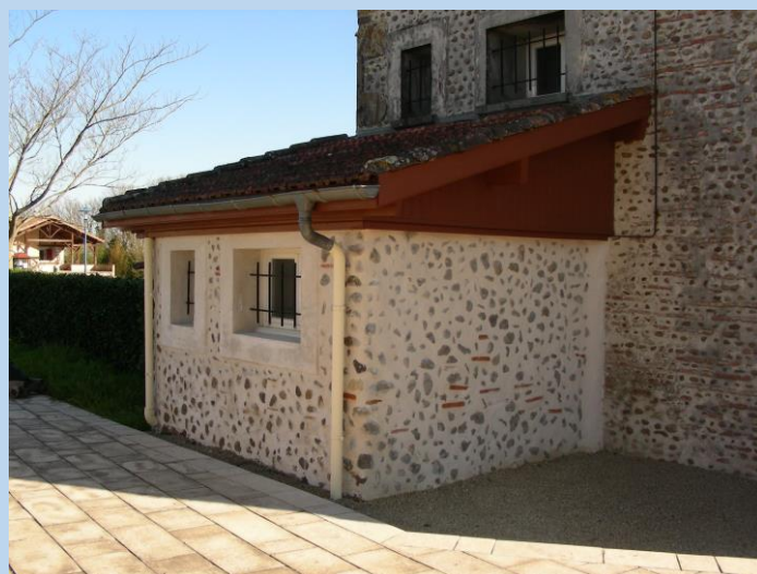
Les travaux terminés
