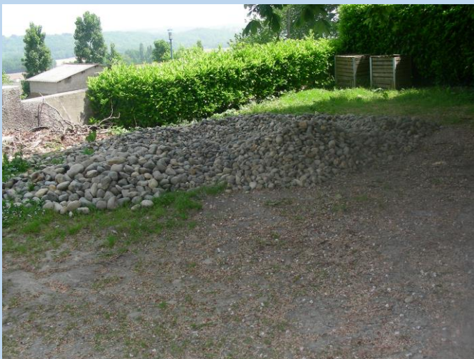
Les galets sont triés avant la mise en place sur les différents murs
