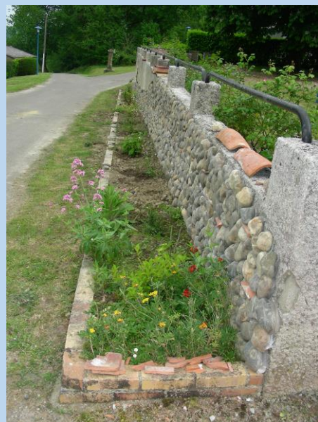
Aménagement en cours
