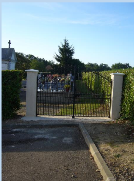
Portail installé en 2011
